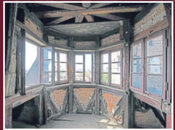
Der Erker des geplanten Turmstüberls
